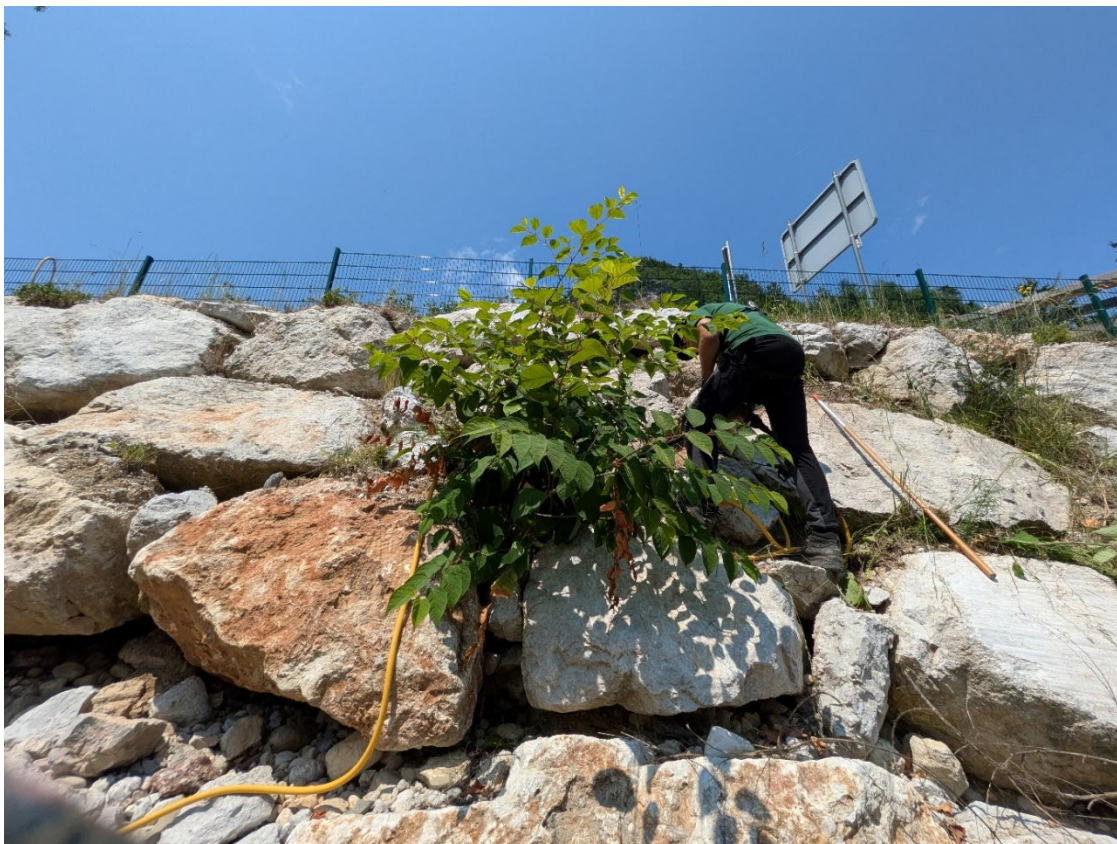
Slika 6. Odstranjevanje dresnika z elektriko v kamniti zložbi ob Radovni. Foto: arhiv Zavoda Symbiosis, junij 2025
