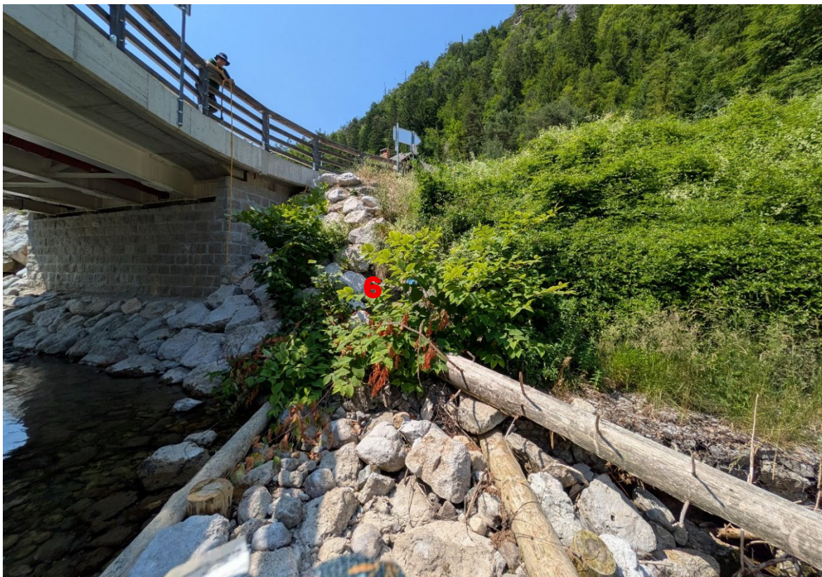
Slika 5. Žarišče japonskega dresnika dolvodno od mostu pred odstranjevanjem z elektriko. Navedena številka ustreza zaporednim žariščem na sliki 2. Foto: arhiv Zavoda Symbiosis, junij 2025
