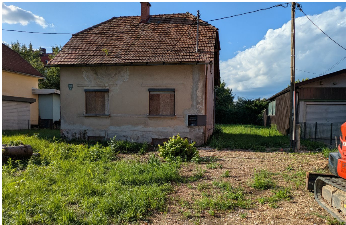
Slika 15. Pri prvem pregledu žarišča Nove Fužine smo opazili obsežne odprte površine zaradi polaganja kanalizacijskih cevi. Foto: arhiv Zavoda Symbiosis, julij 2025
