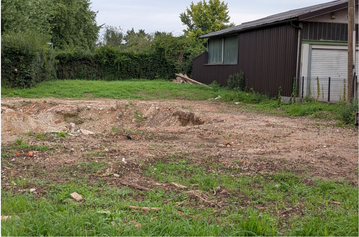
Slika 16. Pri drugem pregledu v septembru je bila stanovanjska hiša že porušena. Zaradi premikanja zemljine je vsekakor smiselno, da se žarišče spremlja še eno leto. Foto: arhiv Zavoda Symbiosis, september 2025
