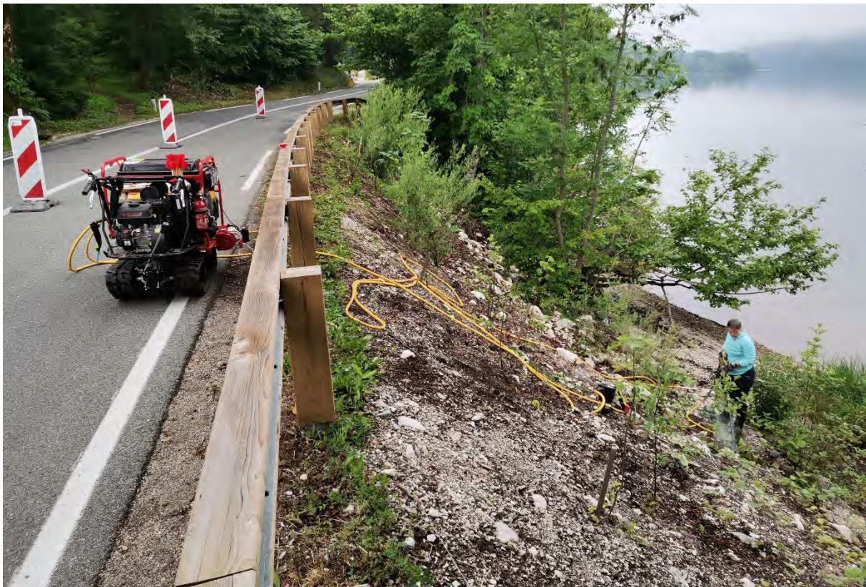
Slika 35. Zaradi strmega pobočja na žarišču Bohinj I smo morali delovni stroj za zatiranje z elektriko postaviti na cesto, promet pa je bil začasno urejen izmenično enosmerno. Foto: arhiv Zavoda Symbiosis, junij 2025
