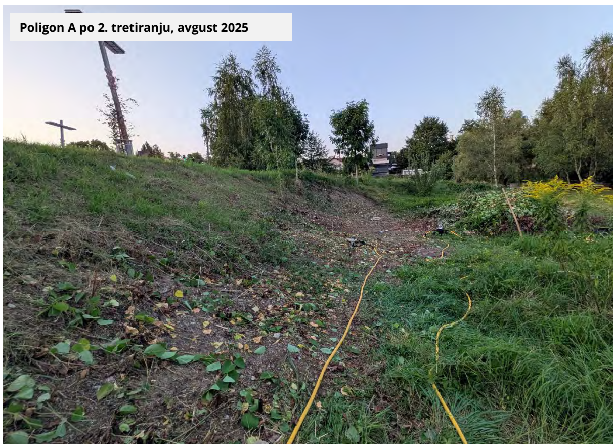
Slika 29. Stanje na lokaciji Barjanska cesta, poligon A, pred, in po drugem tretiranju v letu 2025. Pogled proti severovzhodu. Foto: arhiv Zavoda Symbiosis (avgust 2025).
